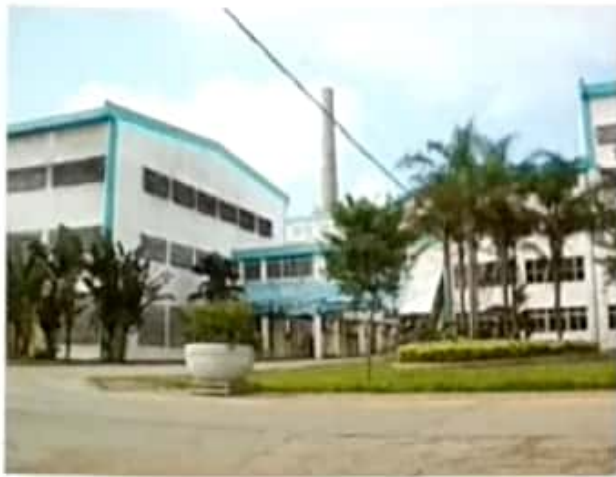
华丰糖厂厂区
